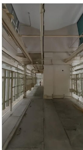
(左) 中3階バルコニーと照明ギャラリー
